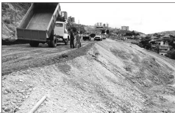
Execução de sub-base de via em obra da SUDECAP/BH
