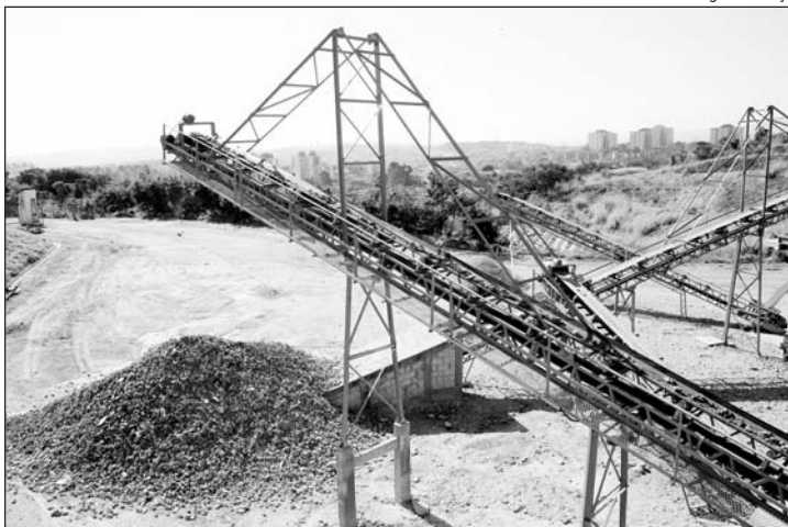
Usina de Reciclagem de Entulho e de Tratamento de Resíduos Sólidos da BR 040 - SLU/PBH
