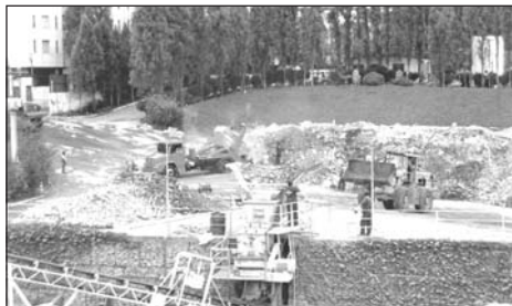
Estação de Reciclagem Pampulha / SLU-PBH
