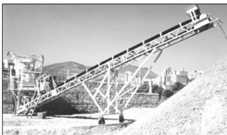
Estação de Reciclagem de entulho Estoril - SLU-PBH
