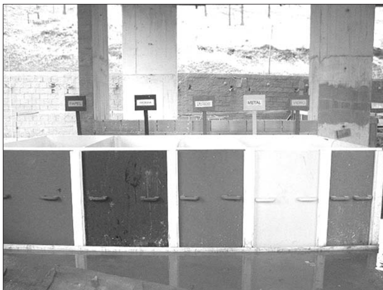
Coleta seletiva de RCC - Construtora Lider
