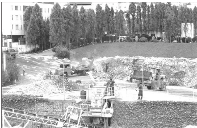
Estação de reciclagem de entulho Estoril/SLU-PBH
